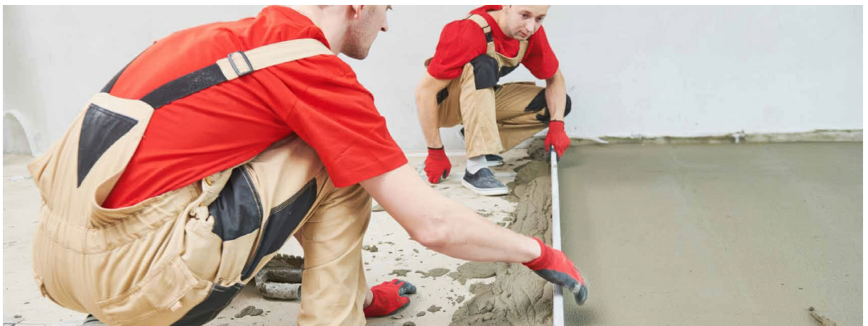
Tworzenie pasów oraz rozprowadzanie i ściąganie materiału na posadźce
