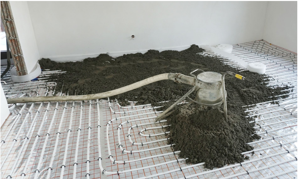
Ogrzewanie podłogowe w garażu
