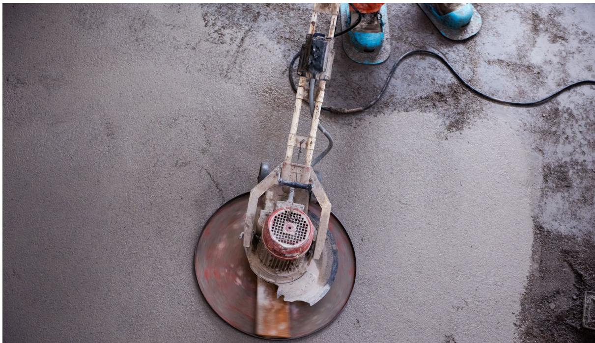
Zacieranie mechaniczne podkładu
