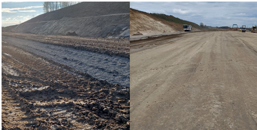
Skuteczność osuszenia gruntu spoiwem hydraulicznym Gruntar HRB E3 – dodatek 2,8% w stosunku do suchej masy gruntu
