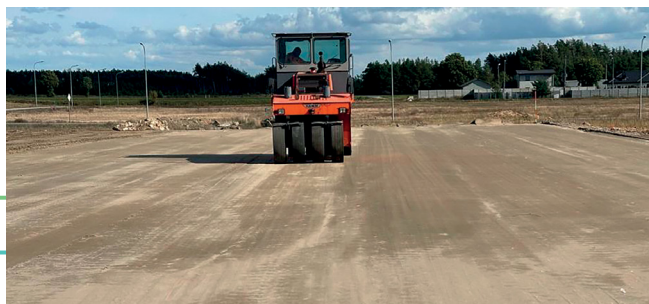
Zagęszczanie stabilizacji – walec stalowy i gumowy
