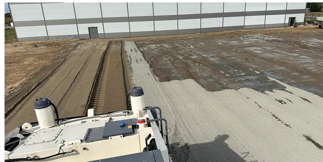
Doprowadzenie gruntu do wilgotności optymalnej, wysiew cementu, mieszanie gruntu
