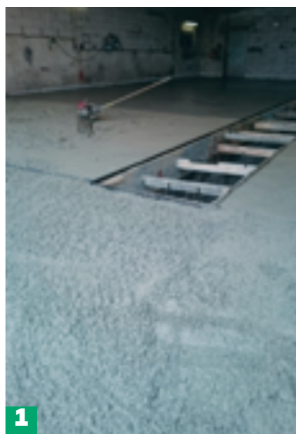
Fot. 1, 2. Proces układania mieszanki betonowej (fot. Holcim)
